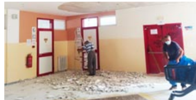
Φωτογραφία από τις εργασίες αποκατάστασης της ζημιάς
